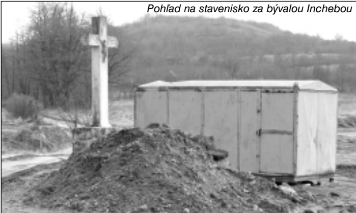
Pohľad na stavenisko za bývalou Inchebou
