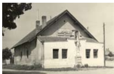
Budova požiarnej zbrojnice
