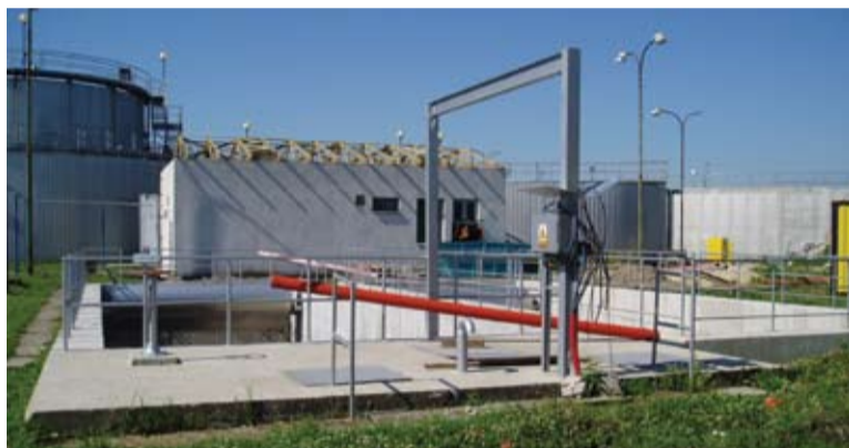
Dažďové nádrže, v pozadí rekonštrukcia duchárne
