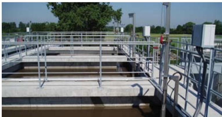
Objekt SO 03 anaerobný reaktor a anoxický regenerátor v čase komplexných skúšok
