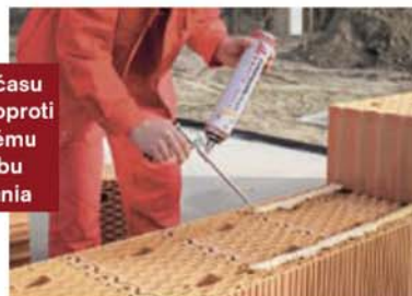
Pohľad na nanášanie PU peny DRYFIX extra pomocou aplikačnej pištole
