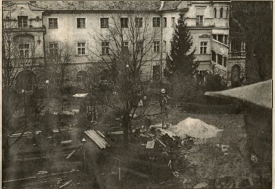
V súčasnosti prebieha v Domove dôchodcov rozsiahla rekonštrukcia kanalizačného systému a stavebné práce na odstraňovaní následkov poslednej povodne.
