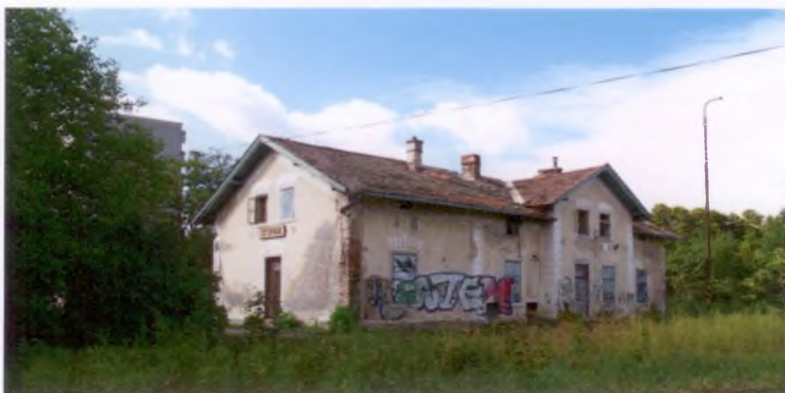
Staničná výpravná budova, pohľad z koľajiska. Foto: Milan Greguš, 2012
